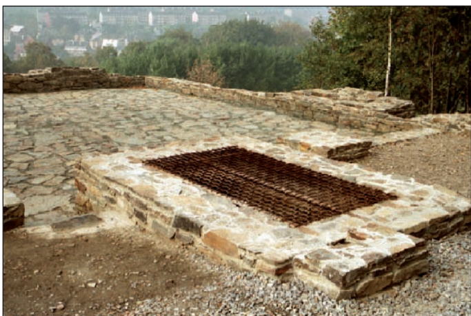
Sanierung 1992 mit vergittertem Schacht, der sich ursprünglich in der Mitte des Gebäudes befand
