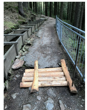
Das Loch im Weg mit einem Hohlraum von ca. 1 x 1 Meter unter dem Beton, Erstsicherung und Absperrung durch Kollegen Steffen Brunner
