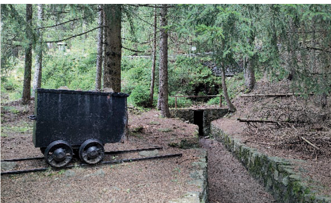
Heutiger Mundlochbereich in Bruchsteinbauweise
