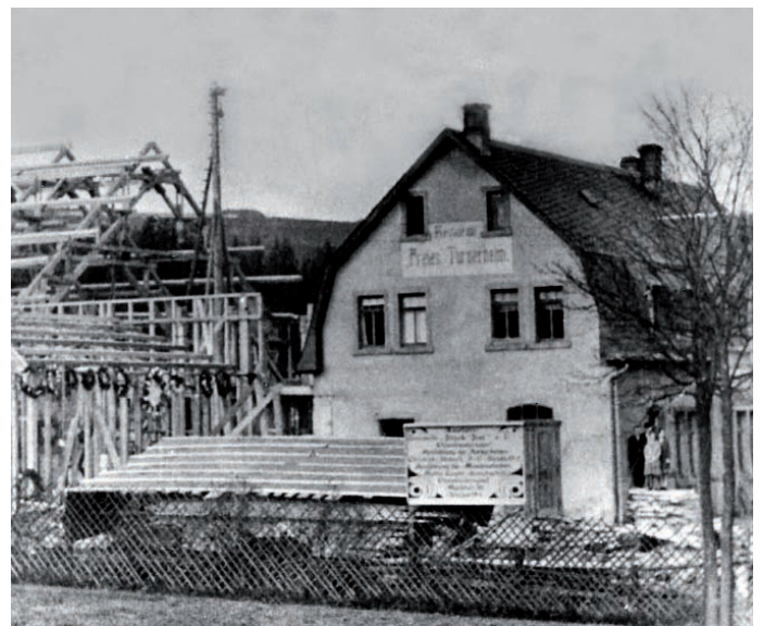
Bau 1928, Foto: Archiv
