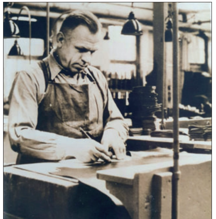
Albin Hertel arbeitete in der Zuschneiderei. Vor dem Einsatz der Schwenkarmstanzen wurden die Oberlederteile mit scharfen Zuschneidmessern mittels Schablonen ausgeschnitten.
