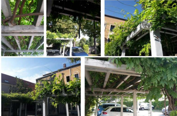
Beispiel: Holzpergola mit engem Stützensystem einschließlich Großgrün/Mauerbegrünung, STEG Dresden Quelle: die STEG Stadtentwicklung GmbH
